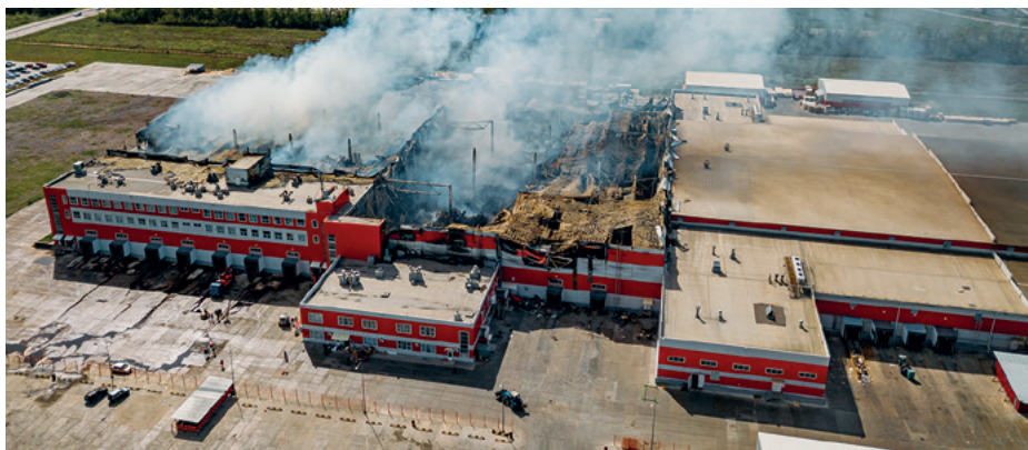
Ein Brand kann einen Betrieb empfindlich treffen: Neben Flammen, die ihre Spuren hinterlassen, führen Rauchgase und Löschwasser oft zu erheblichen Schäden.
